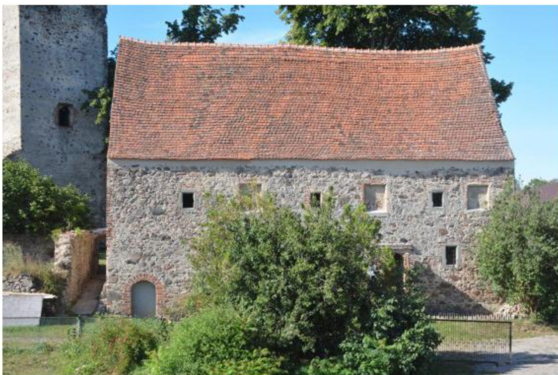
Konserwacja dachu Złotnik Fot. A. Gutka
