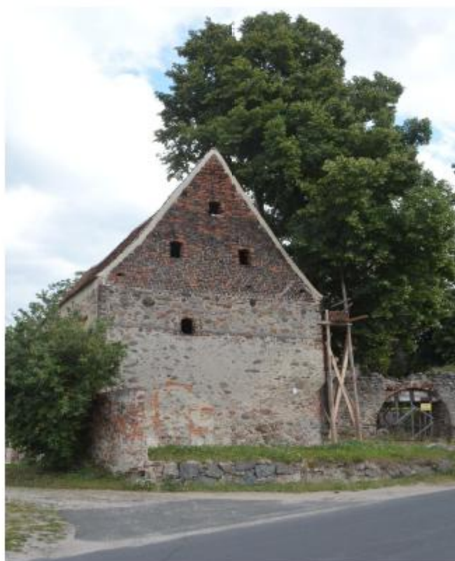
Rusztowanie – remont dachu Złotnik Fot. A. Gutka
