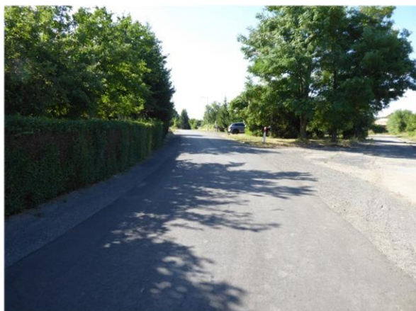
Budowa drogi w m. Bieniów
