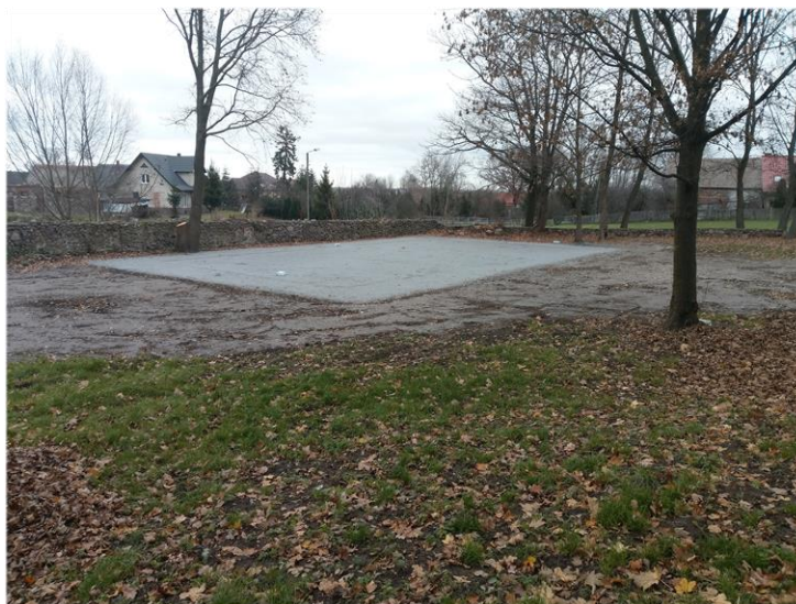
Wykonanie boiska do siatkówki i koszykówki w Lubomyślu
