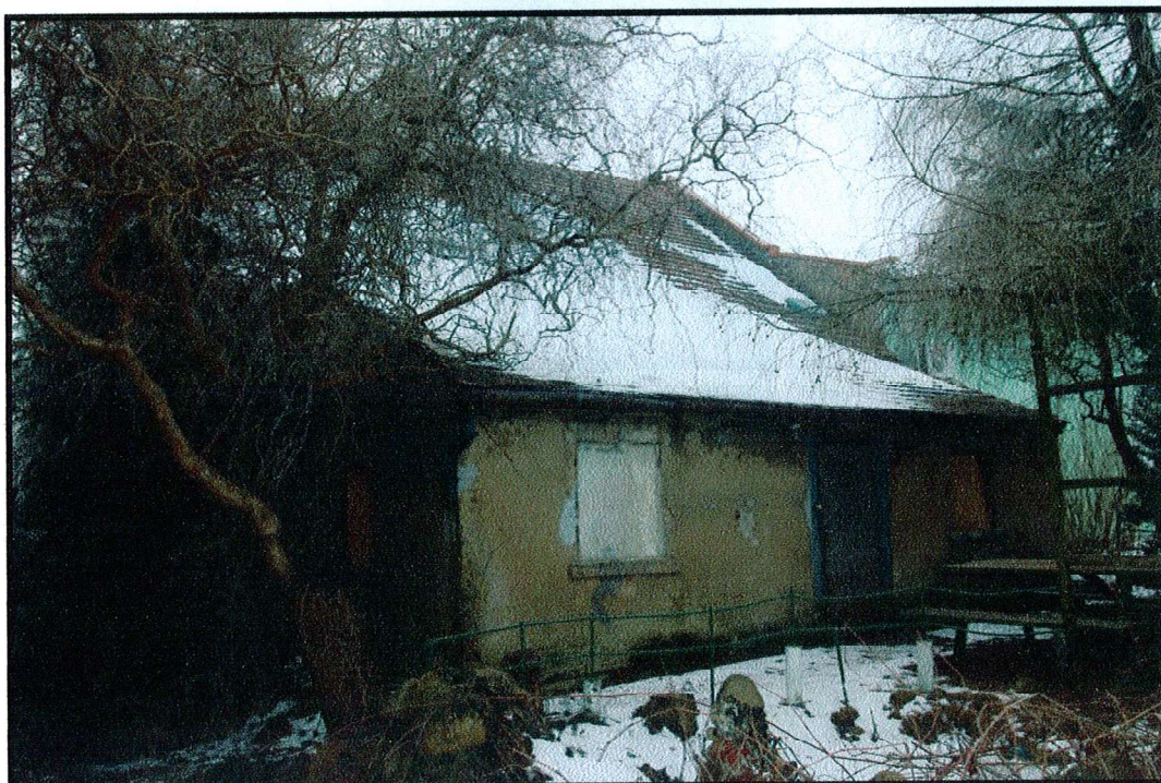
Fotografia 6: Widok na przybudówkę stanowiącą północno - zachodnią elewację inwentaryzowanego budynku.
