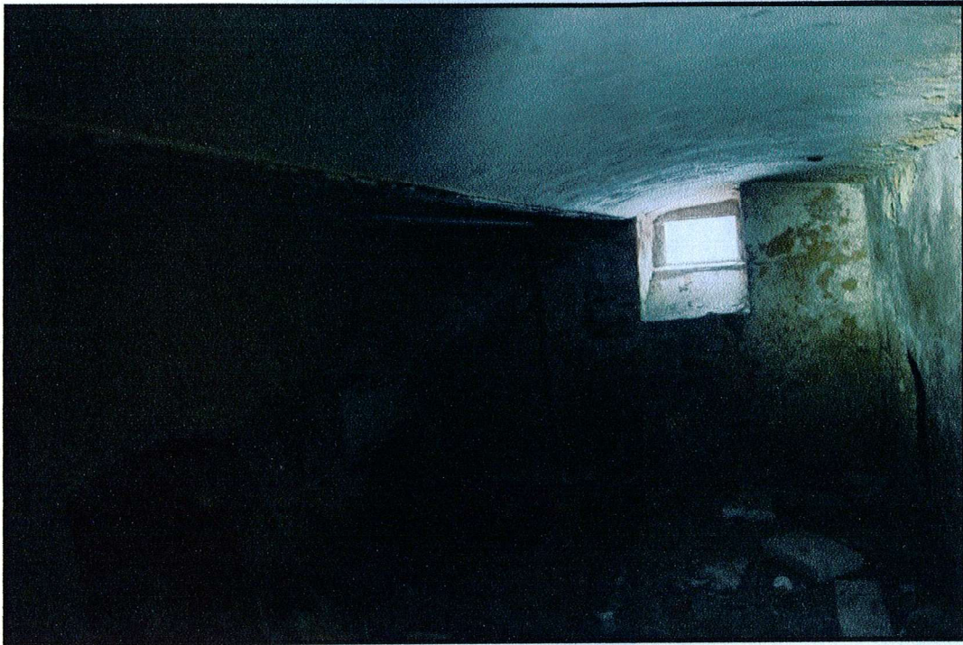
Fotografia 3: Widok na podpiwniczoną część budynku. Mimo dogodnego mikroklimatu który mógłby sprzyjać wykorzystywaniu przestrzeni przez nietoperze nie stwierdzono śladów bytowania tych ssaków. Spowodowane jest to brakiem szczelin, które mogły by zostać wykorzystane jako przestrzeń do hibernacji
