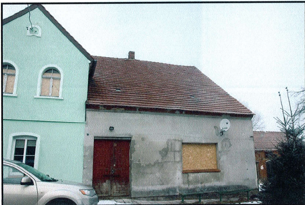
Fotografia 4: Ogólny widok na południowo- wschodnią elewację inwentaryzowanego budynku.
