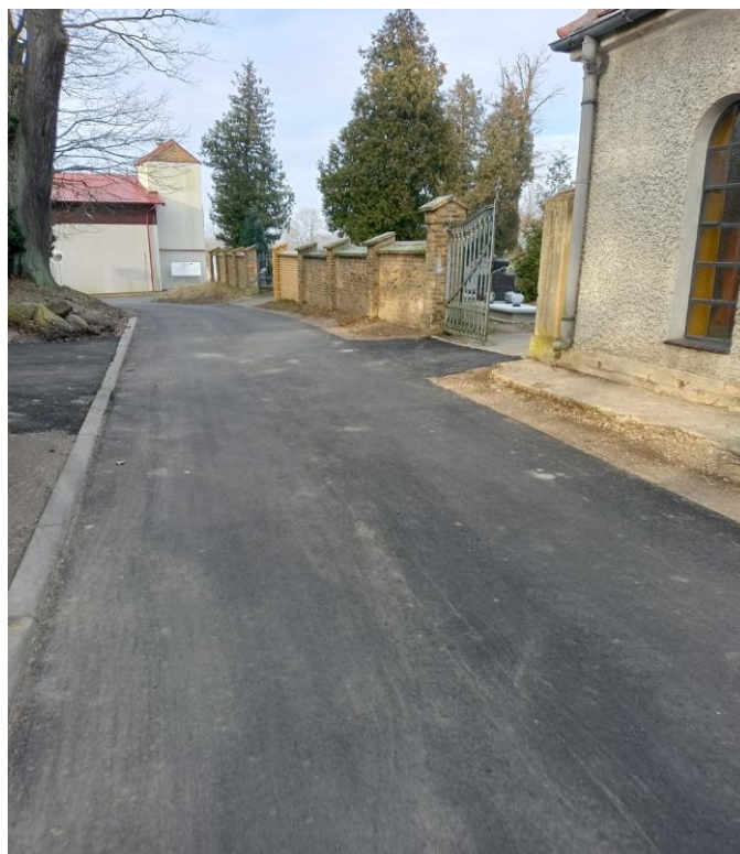
Budowa drogi wewnętrznej w m. Sieniawa Żarska dz. nr 582
