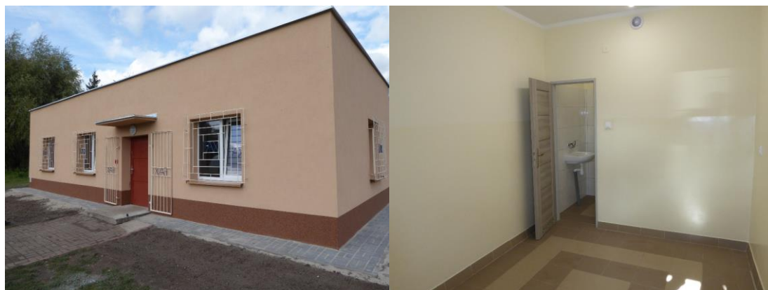
Modernizacja szatni sportowej w Bieniowie
