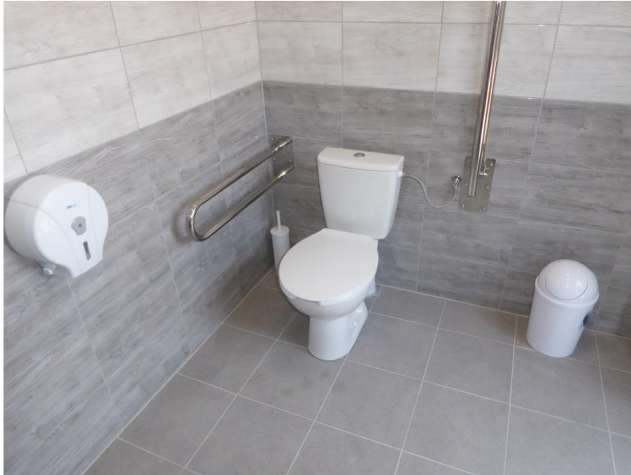
Budowa toalety zewnętrznej przy świetlicy wiejskiej w Mirostowicach Górnych
