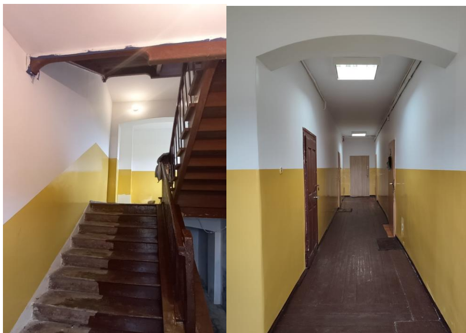
Remont klatki schodowej Marszów 35
