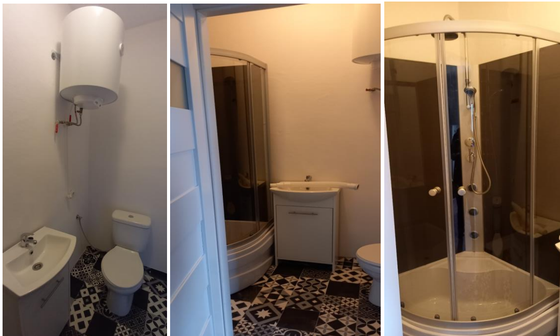
Wykonanie łazienki Marszów 35
