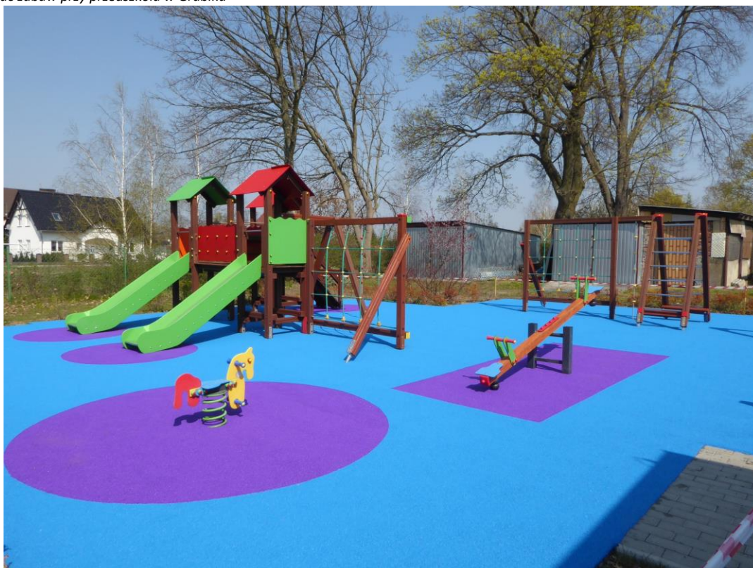
Modernizacja/rozbudowa placu zabaw przy przedszkolu w Grabiku
