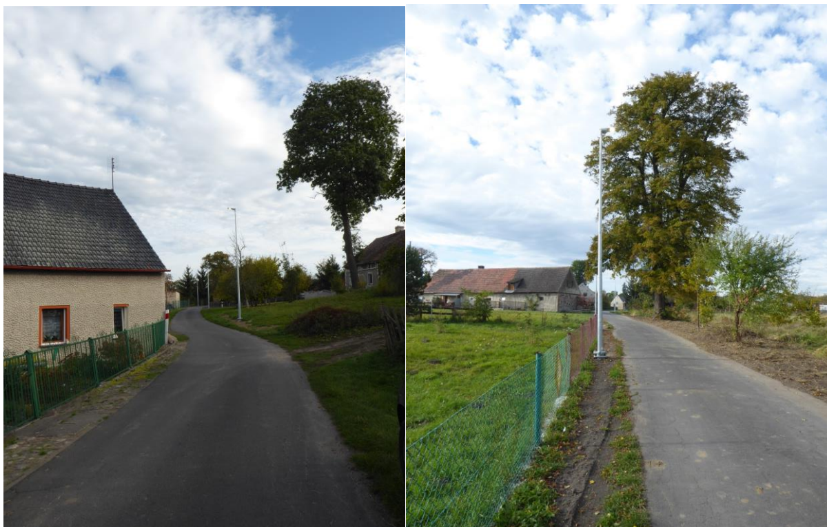
Oświetlenie drogowe Złotnik
