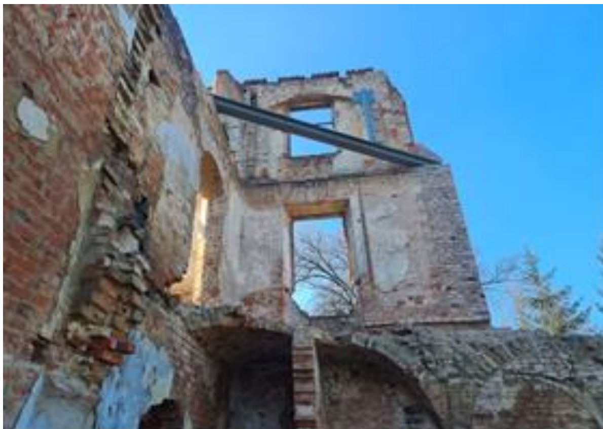
Stabilizacja i zabezpieczenie ścian z konstrukcji stalowych 2021r.
