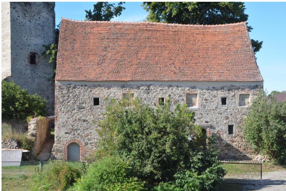
Konserwacja dachu Złotnik Fot. A. Gutka
