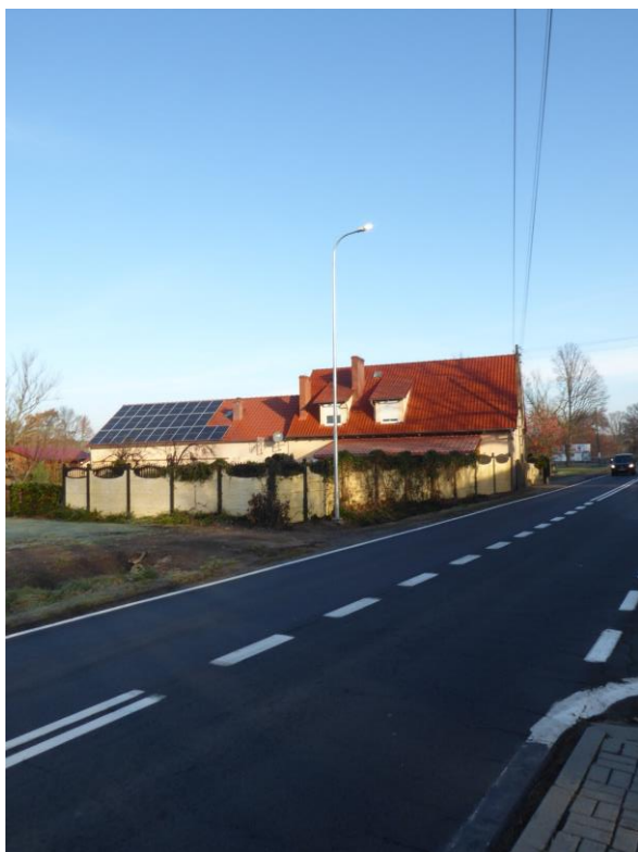
Oświetlenie drogowo w m. Dąbrowiec
