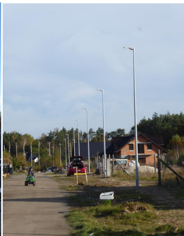
Oświetlenie drogowo w m. Mirostowice Dolne ul. Leśna
