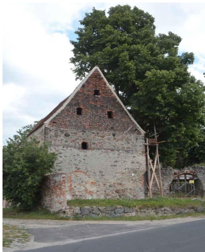
Rusztowanie – remont dachu Złotnik Fot. A. Gutka
